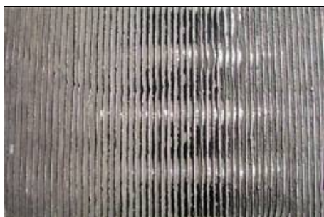
薬剤散布洗浄済フィン 差圧 2.2KPa
