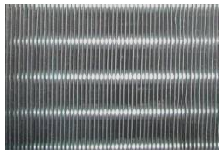
超高圧洗浄済フィン 差圧 0.8KPa
