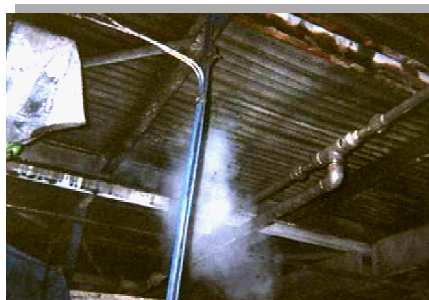
エアフィン下部の作業
